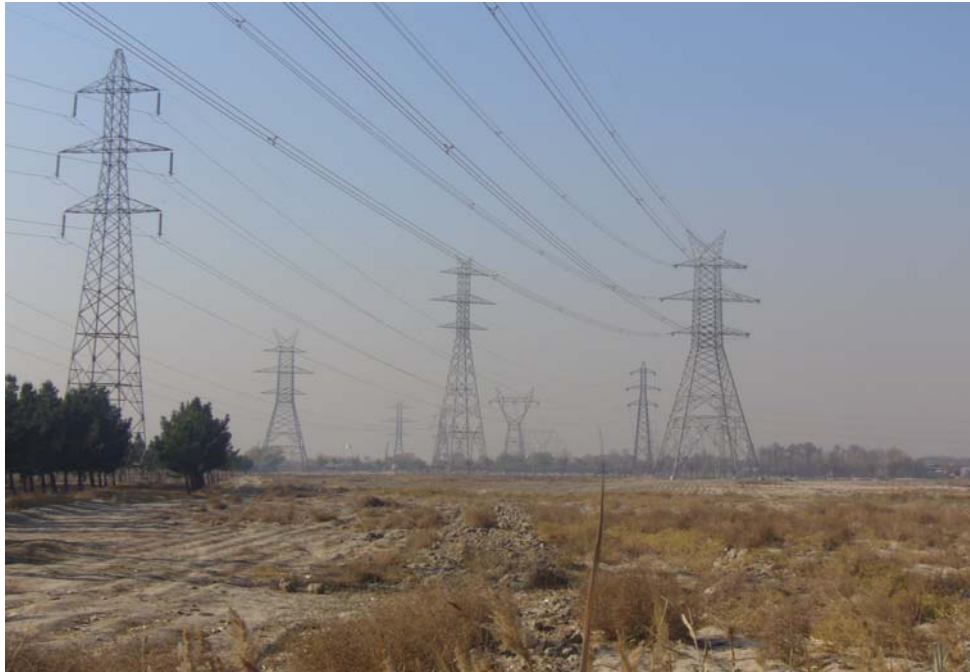
شکل ۱۸) نمایی از خط انتقال دومداره
