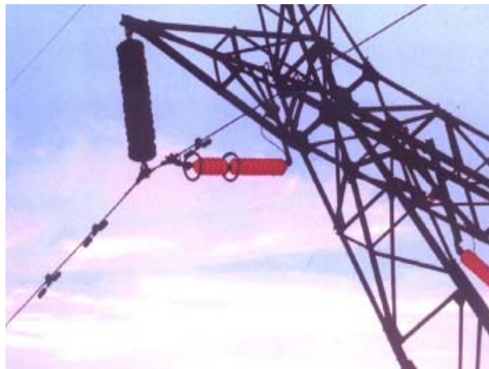
شکل ۴۵) استفاده از برقگیر خط بر روی دکل
