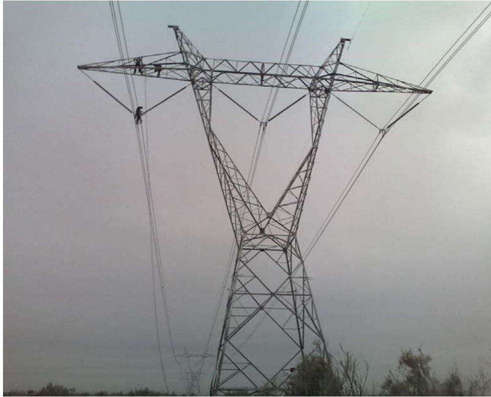
شکل (۱۷) نمایی از خط انتقال تکمداره
