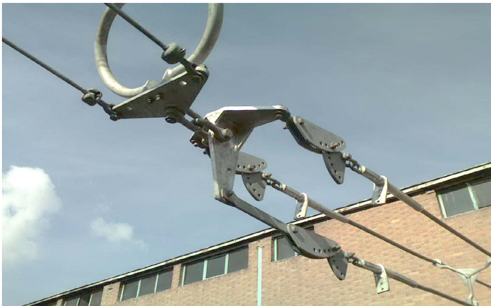
شکل ۴۰) استفاده از Socket Clevis , Yoke Plate , Arcing Rocket , Shackle , Extension Link, Sag Adjuster , Dead End Clamp , Spacer
