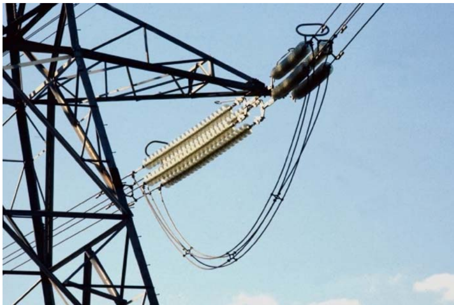
شکل ۳۲) نصب موازی زنجیره مقره ها
