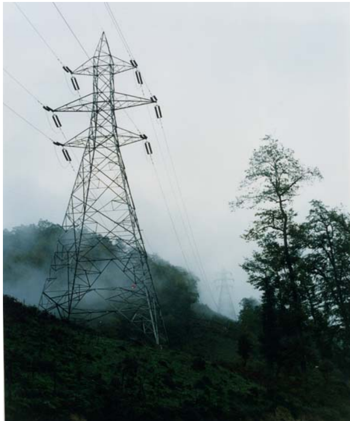
شکل ۱۸) نمایی از خط انتقال دومداره
