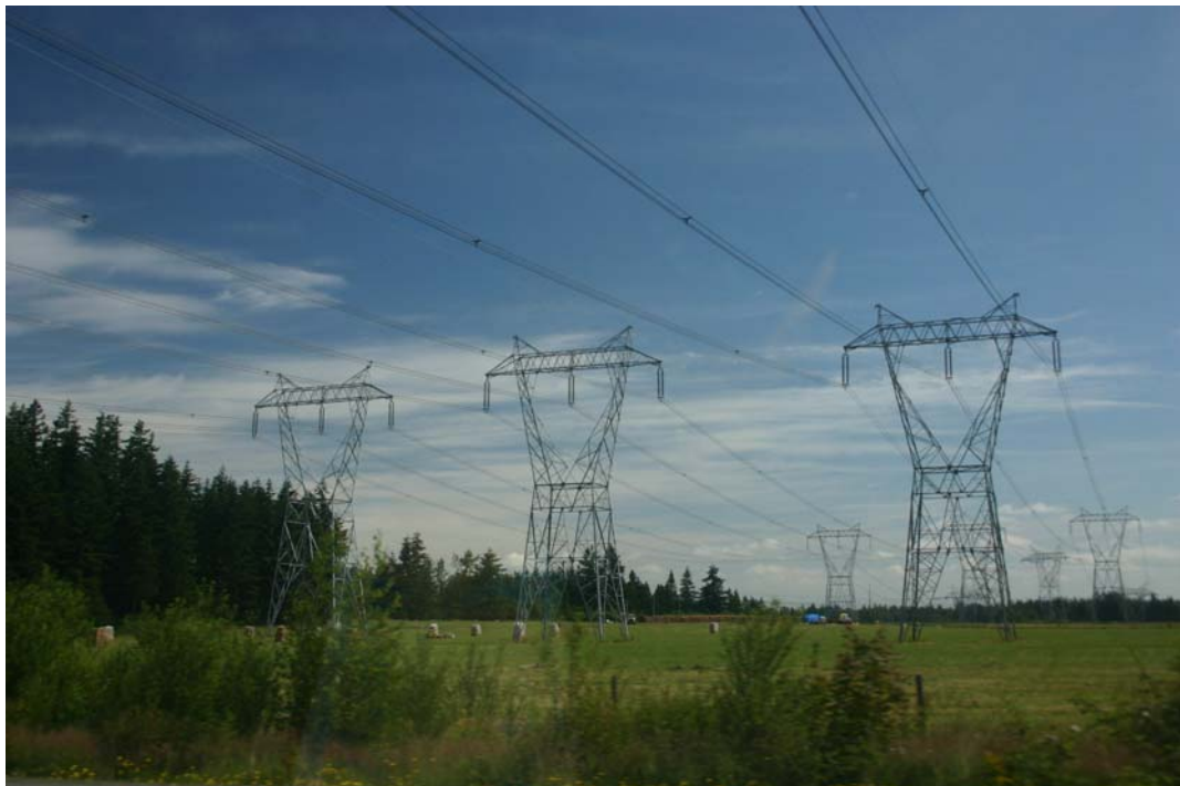
شکل ۱۰) برج با آرایش افقی هادیها
