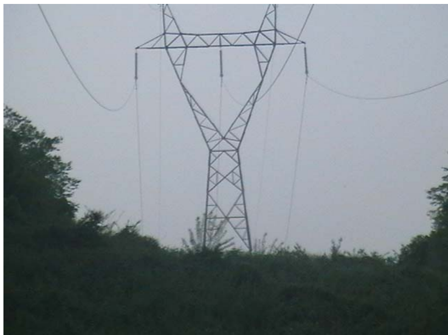
شکل ۱۴) نمایی از یک برج آویزی
