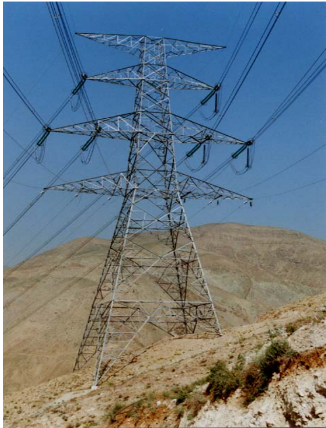
شکل ۱۹) خط انتقال چهارمداره
