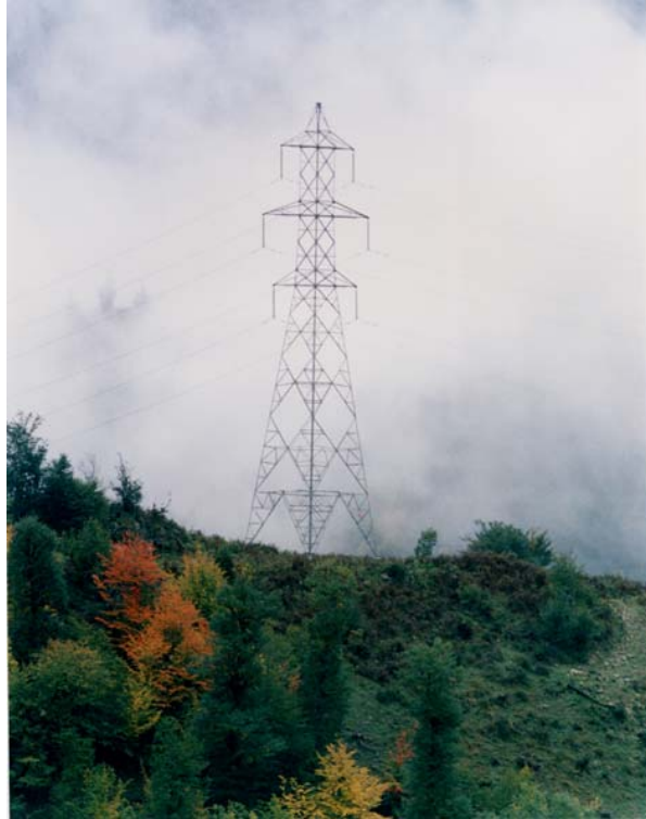
شکل (۱۱) خط انتقال با آرایش عمودی فازها
