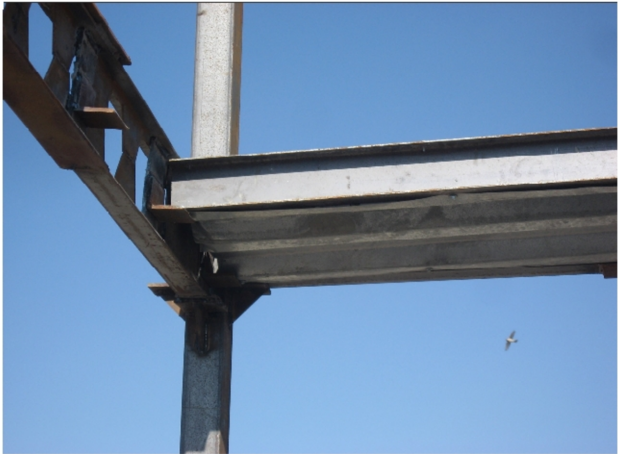
نحوه قرار گیری سقف بر روی نبشی نشیمن
